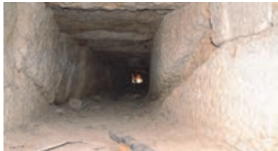
شکل ۱- سامانه انتقال فاضلاب در تخت جمشید
